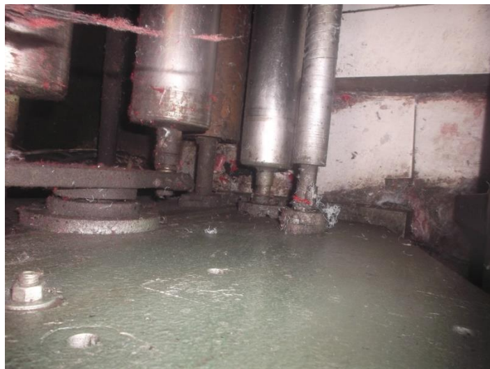
Figura 48. Parte interna de la máquina, acumulación de fibras y aceites (Cortesía Textiles ARRO SAS)
