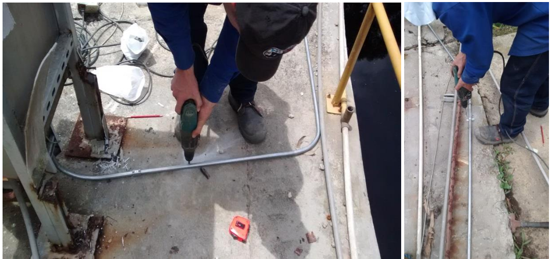
Figura 15. Instalación de tubería eléctrica. Tomada por el autor.
