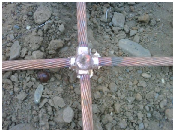
Figura 3. Unión de cables de puesta a tierra por soldadura exotérmica. (M.Martins, 2012)
