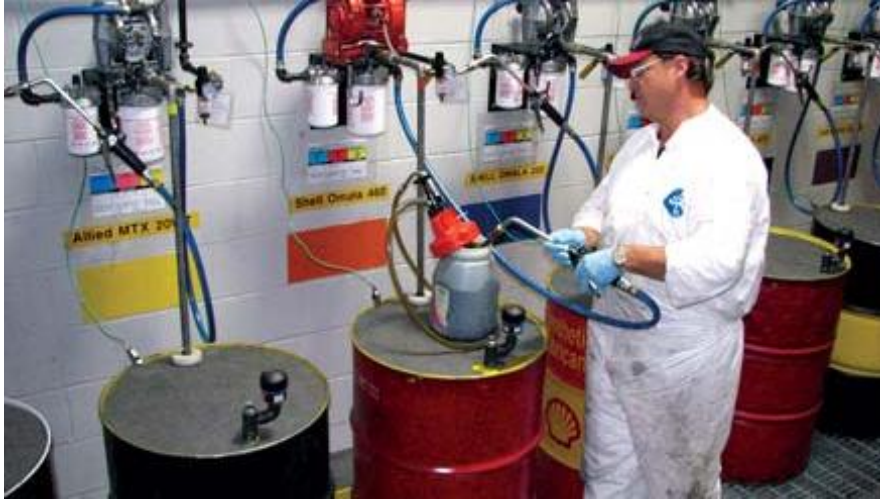
Figura 91. Área de lubricación. (www.maquinariaspesadas.org, 2015)
