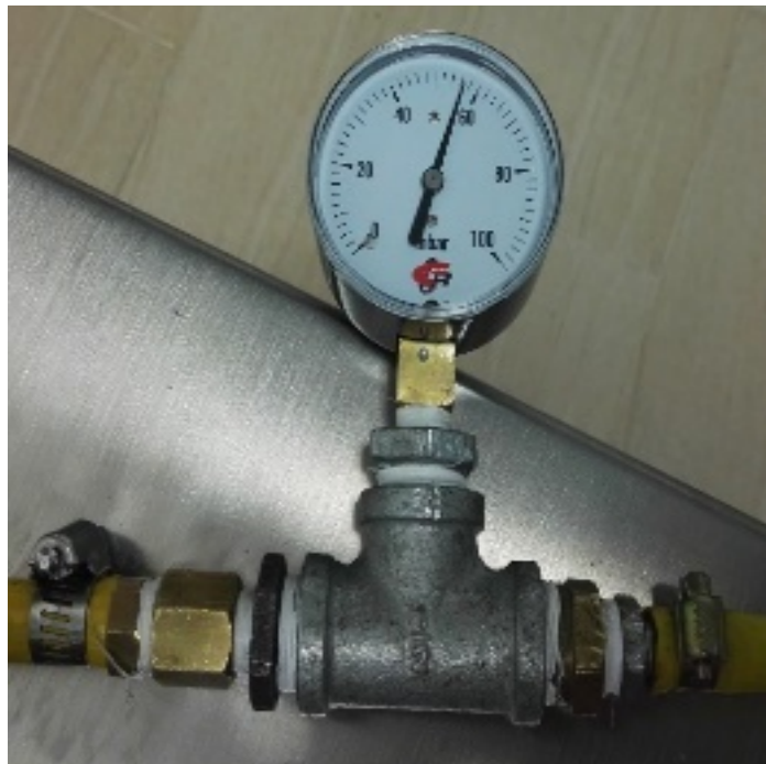
Figura 23. Manómetro de suministro de gas.
