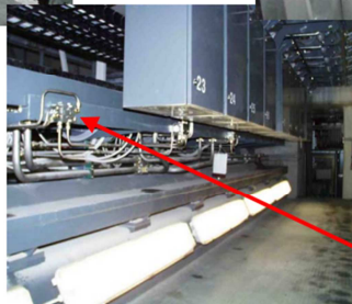
Imagen 19 Sistema básico de lubricación utilizado por Lincoln (Sistemas de lubricación Lincoln en la industria papelera, 2013)
