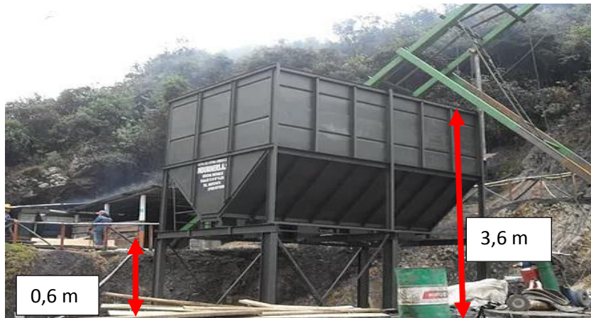
Figura 18. Tolva encargada de almacenar el carbón en la mina.
