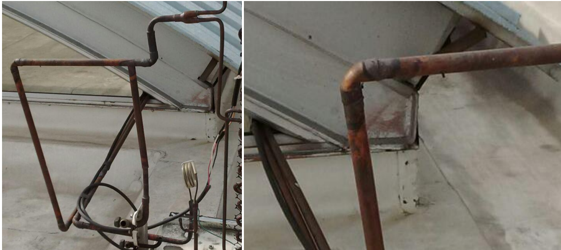
Figura 38. Codos y T soldados Fuente propia.
