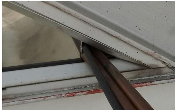
Figura 37. Trabajo necesario en el ventanal del laboratorio. Fuente propia.
