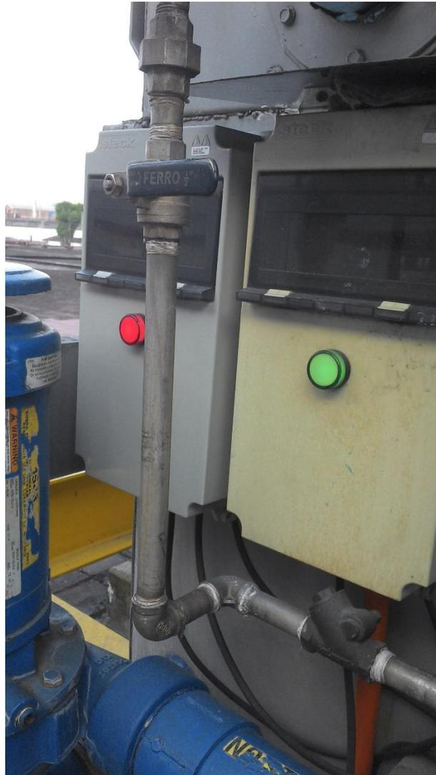
**Fig. 11.** Cajas de control de nivel en torre. Fuente: Autor
