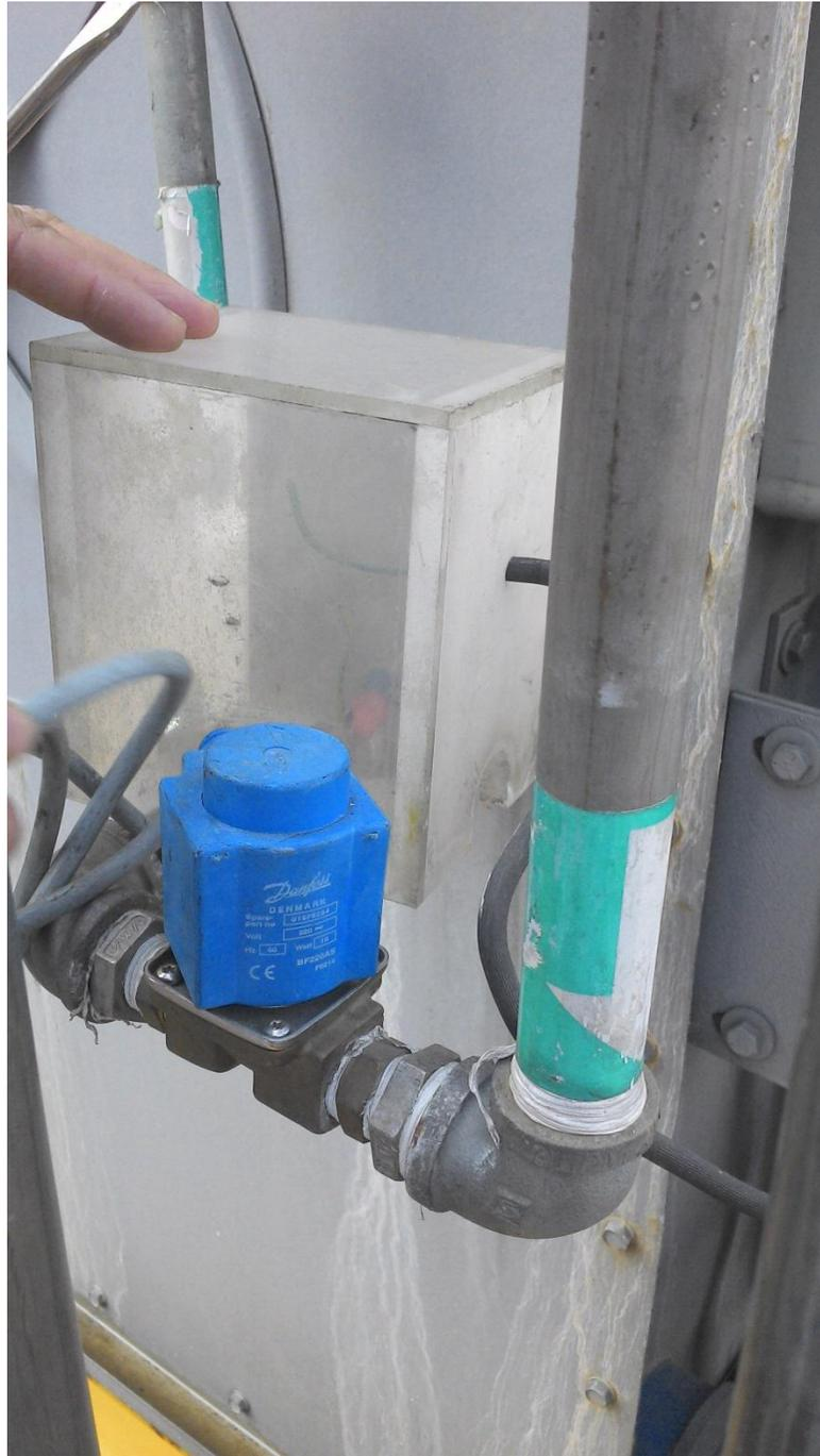
Fig. 12. Válvula eléctrica en torre. Fuente: Autor
