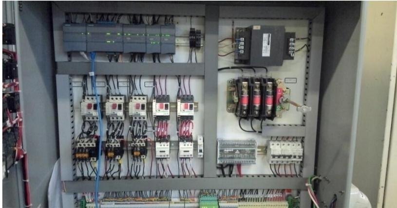
**Fig. 6.** Distribución de elementos en tablero. Fuente: Autor
