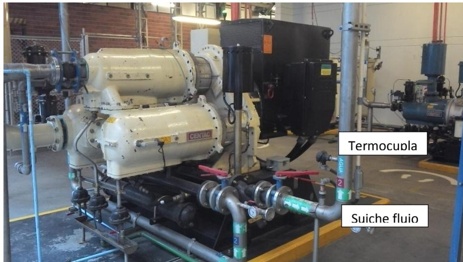
**Fig. 9.** Sistema de enfriamiento compresor 4 con elementos. Fuente: Autor
