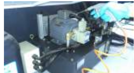
Imagen 4.5. Soplar con aire comprimido.
