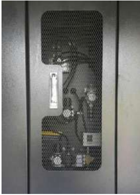
Imagen 9.1. Puerta de acceso a válvula paso de aire.
