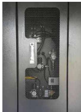
Imagen 4.1. Puerta de acceso a válvula paso de aire.
