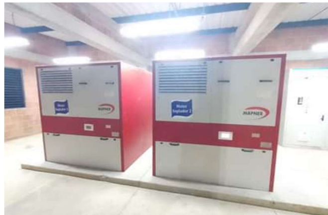
Figura 20 Soplador (Aireador). Fuente: ESPY
