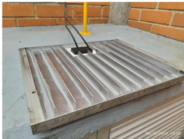
**Figura 22.** *Disipador instalado en la parte inferior del panel fotovoltaico.*
