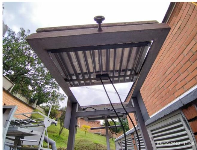
**Figura 26.** *Parte inferior del panel fotovoltaico sujeto en la estructura.*
