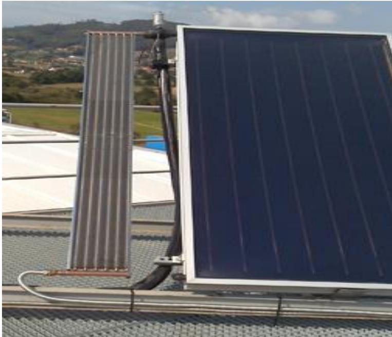
**Figura 5.** Panel solar conectado con disipador de calor. Tomada de Inditer (2020).
