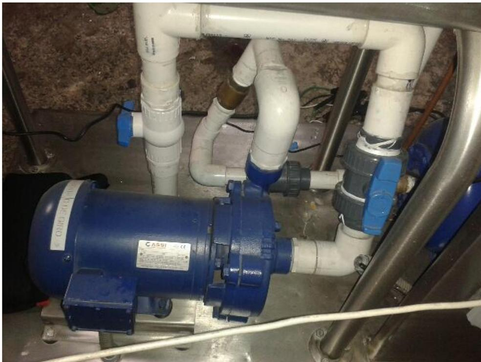
Figura 8. Base de la planta de presión con motobomba.
