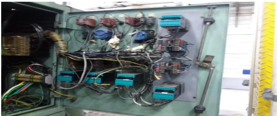
Figura 9. Puerta cabina1. (Imagen autoría propia.)
