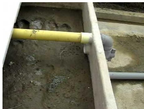
Figura 11 - Tanques de almacenamiento de Lodo Digerido
