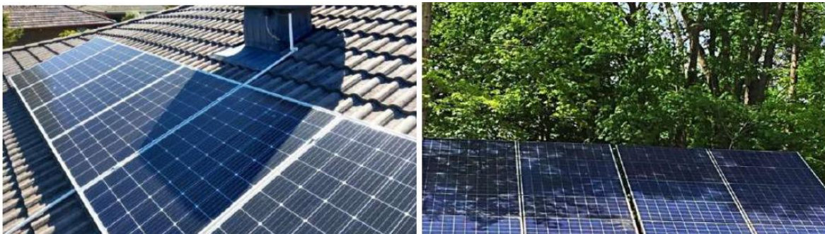
Figura 3. Sombreado parcial proveniente de árboles y de objetos que están cerca de las celdas. [3]
