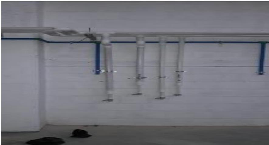
Figura 27. Tubería en PVC para el suministro de agua utilizada para la refrigeración de las máquinas.
