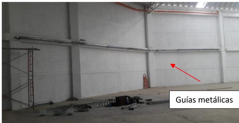
Figura 25. Instalación de la guía metálica para el cableado de alimentación de las máquinas extrusoras y sopladora.
