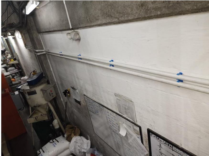
*Figura 13. Tubería de distribución de agua fría*
