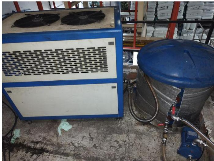
*Figura 12. Conexión Enfriador de agua, tanque y bomba*
