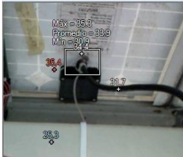
Figura 40. Imagen termográfica del sensor 2 tomado a las 11:01 am septiembre 23.
