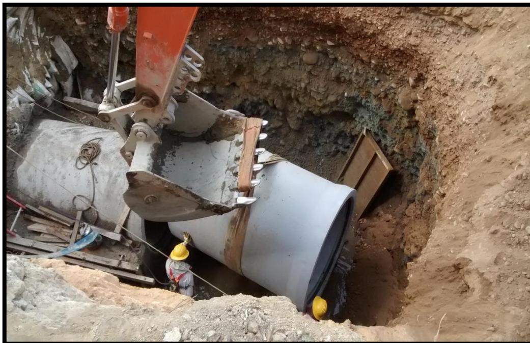
**ANEXO R. Instalación de tubería en PVC para aguas lluvias con mesa en triturado de ¾.**
