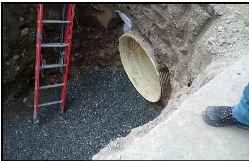
**ANEXO S. Instalación de tubería American Pipe para acueducto.**
