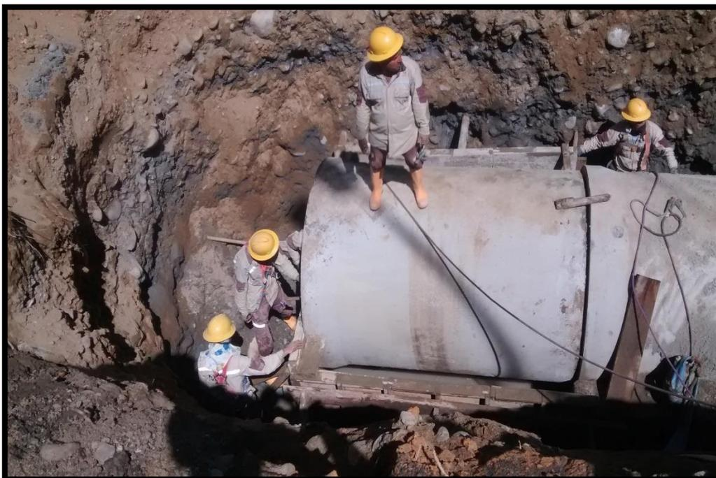
**ANEXO O. Cambio de dirección en tubería en PVC para aguas lluvias.**
