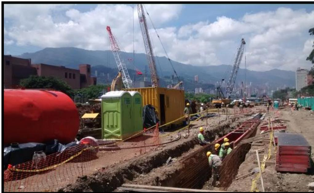
**ANEXO Q. Instalación de tubería en concreto de 60".**
