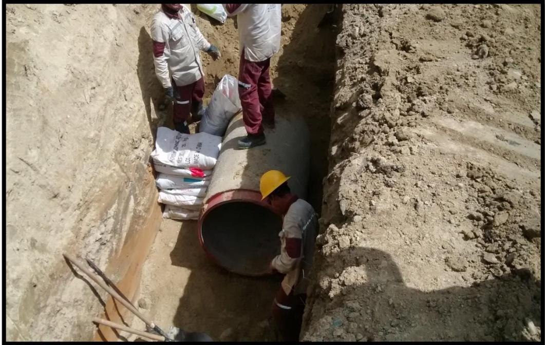
**ANEXO T. Soldadura en unión de tubería American Pipe.**
