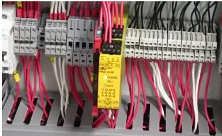
Figura 13. Relé de seguridad
