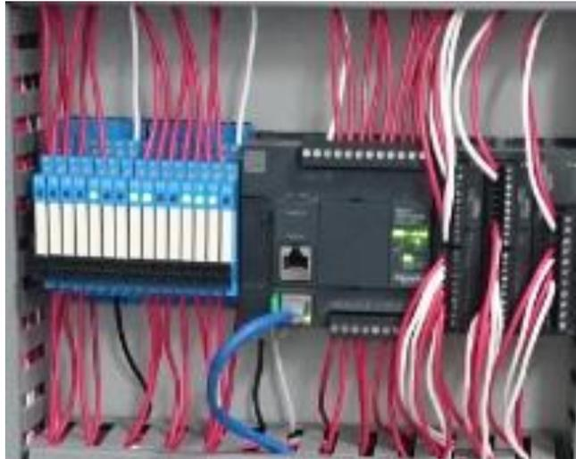
Figura 5. PLC seleccionado con los módulos de trabajo
