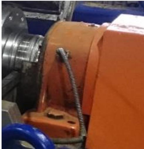
Figura 12. PT100 temperatura en rodamientos.
