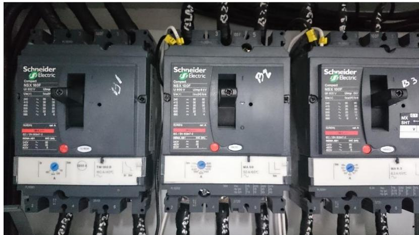
Figura 4. Sistemas protección de la decantadora.
