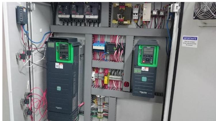
**Figura 16. Nuevo sistema de control implementado en la decantadora**
