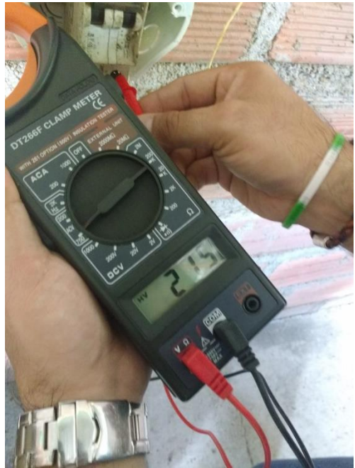
Figura34: Foto real medición de voltaje en el motor ventilador de la secadora.
