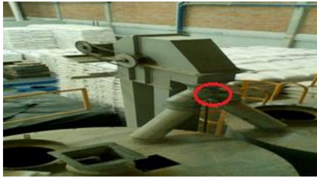
Fig. 9. División superior de los silos. Fuente: Autor.
