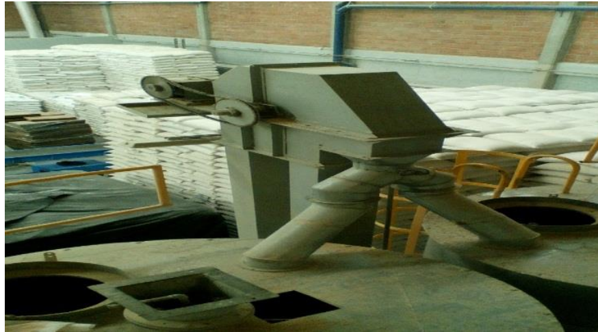
Fig. 32. Vista superior de los silos en la torre. Fuente: Autor.
