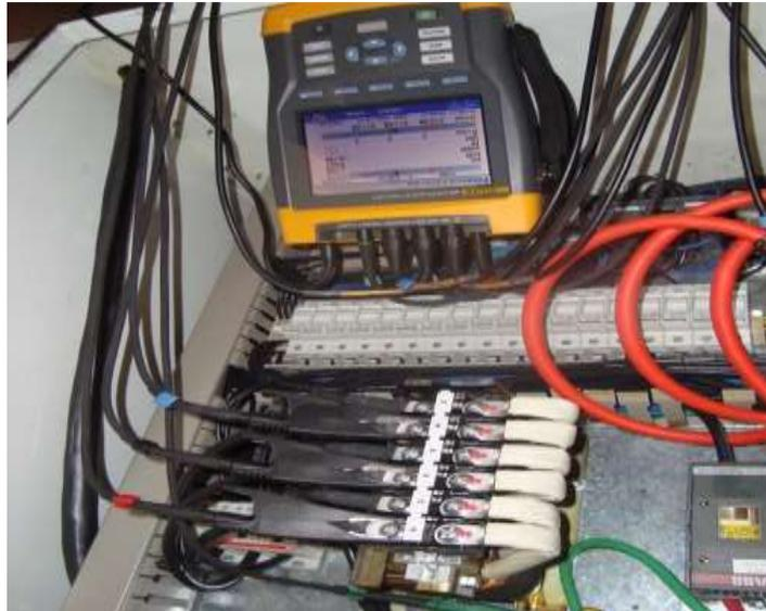
Figura 21. Analizador de redes para medir la potencia.
