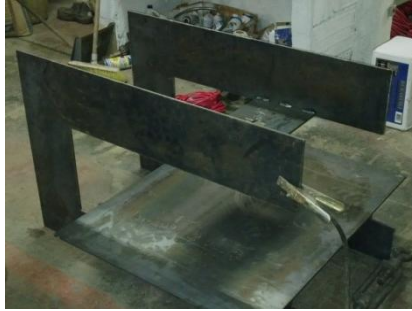
Figura 21. Unión de piezas mediante soldadura MIG.
