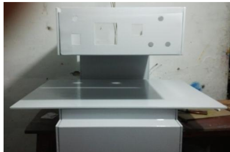
Figura 26. Aplicación de Poliuretano.
